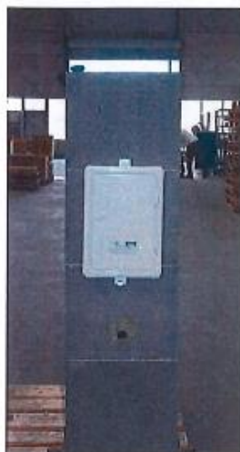
1. Fertigfuß aufstellen und ausrichten.
