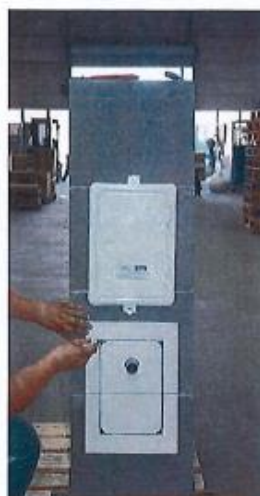
3. Ausschnitt-Ecken mit einem Stift kennzeichnen
