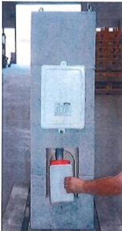
7. Kondensatbehälter einpassen. Dabei darauf achten, dass das Rohr möglichst dicht an der Sammelschale anliegt.
