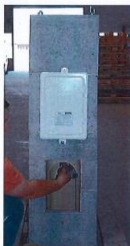
6. Nachdem die Steinstücke entfernt wurden, das HT-Rohr entfernen.
